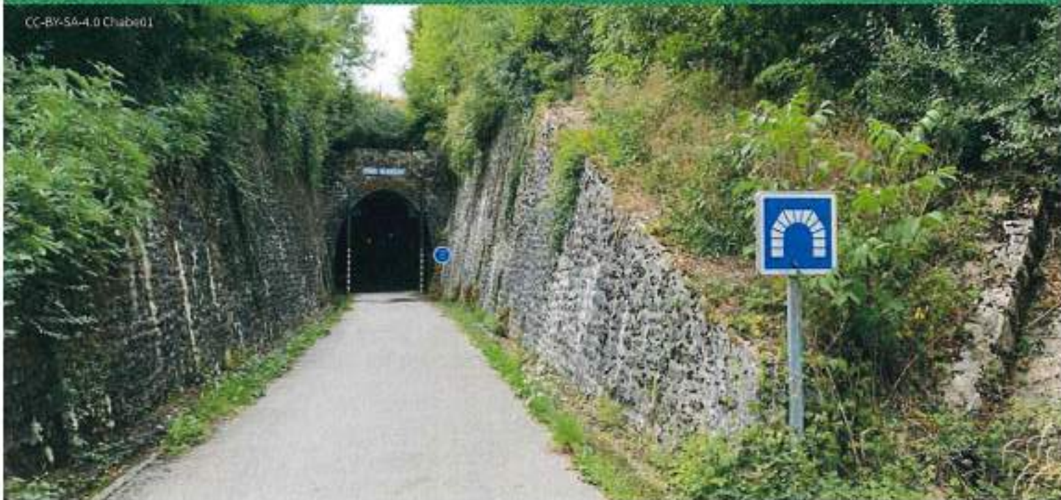
Voie Verte de Bourgogne du Sud, Tunnel du Bois Clair
