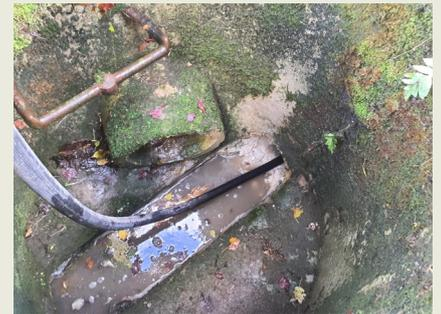
« béton ». Après curage + barre à mine, le réseau reste rempli à 40-50% sur une distance entre 5 et 10 mètres. Suez est à la recherche d'une solution adaptée pour poursuivre le curage mais affirme que l'obstruction n'est pas liée à un ensablement (classique sur les réseaux d'eau pluviale) mais à des déchets de chantier.
